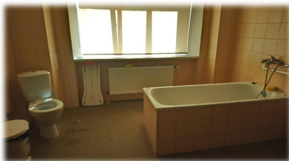
Vannas telpa VSAC "Rīga" filiāles "Ezerkrasti" renovētajā ēkā Berģu ielā 160 (2019.gada 30.maijs)
