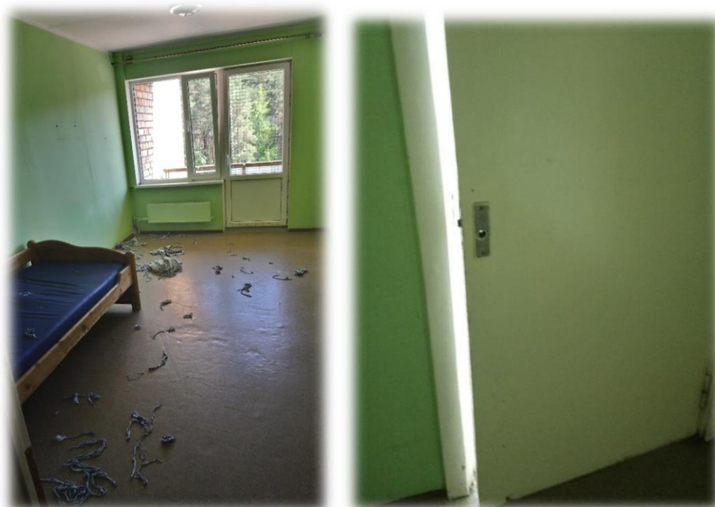
Klienta istaba VSAC "Rīga" filiāles "Ezerkrasti" ēkā Berģu ielā 142 (2019.gada 30.maijs) (Klientam piemīt pašdestruktīva uzvedība, tomēr viņa istabas aprīkojums ir neatbilstošs)
